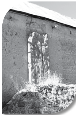
Vista Segundo Contrafuerte.
