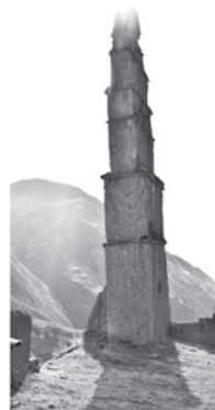
Espadaña: murete a modo de contrafuerte para detener inclinación
