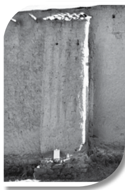
Vista Quinto Contrafuerte.
