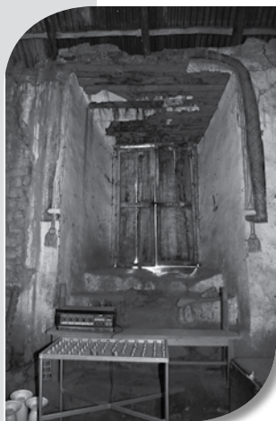
Vano Muro Lateral Der.
