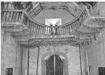
Coro: Sequedad de madera, desintegración de material.
