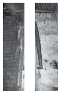
Desprendimiento de Revoque.
