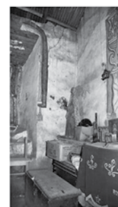
Rajaduras, Cubierta Deteriorada.
