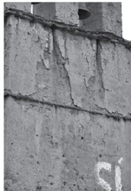
Detalle Desprendimiento de Revoque.
