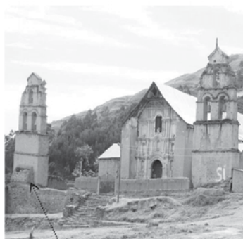
Contrafuerte en la espadaña izquierda.
