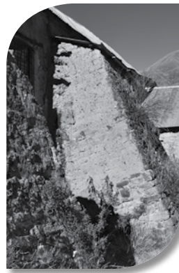
Vista Tercer Contrafuerte.
