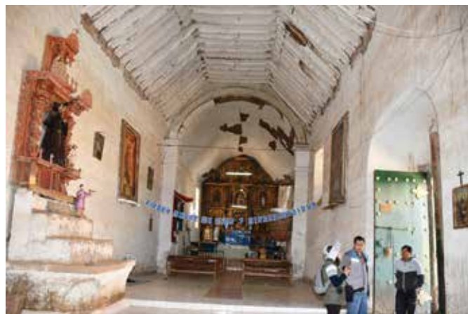
Vista de la Nave Central
