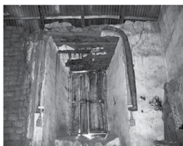
Vista muro de la Sacristía.
