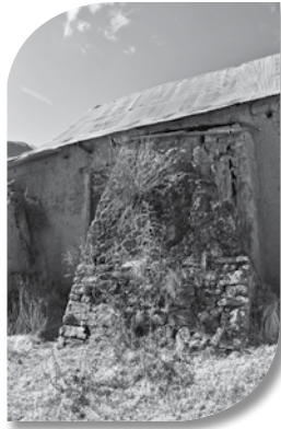
Vista Cuarto Contrafuerte.
