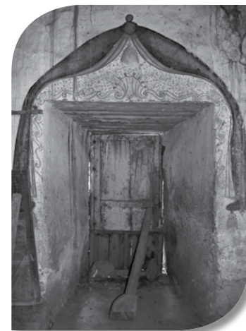
Vano Muro Lateral Izq.
