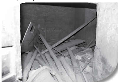
Camerino de acceso al coro actualmente de depósito.
